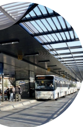
PEM Gare de Mâcon (71) Étude de faisabilité (2012)
