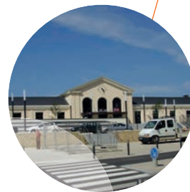
PEM Gare de Laval (53) Étude de faisabilité et expertises (2012)
