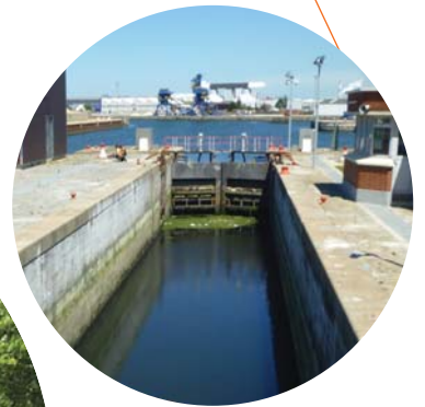
Digue de classe B : VTA, étude de dangers Barrages de classe C : VTA Expertise des ouvrages portuaires du port de Calais (62) [2014-2016]
